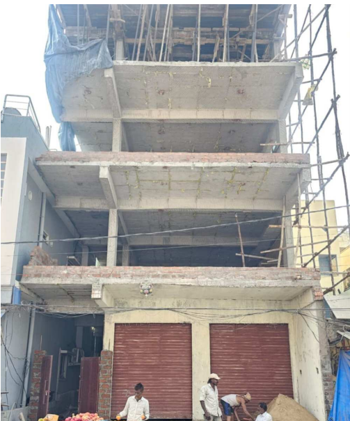
జగద్గిరిగుట్ట చివరి బస్టాప్ పక్కన వెలుస్తున్న నాలుగు అంతస్తుల కమర్షియల్ భవన నిర్మాణం
