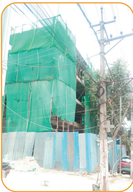
చిత్రారమ్మ ఆలయం ముందు సెల్లార్ & కమర్షియల్ భవన నిర్మాణం
